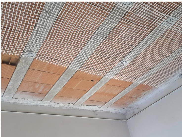
*Figura 10: tipologico posizionamento ed ancoraggio rete antisfondellamento*
